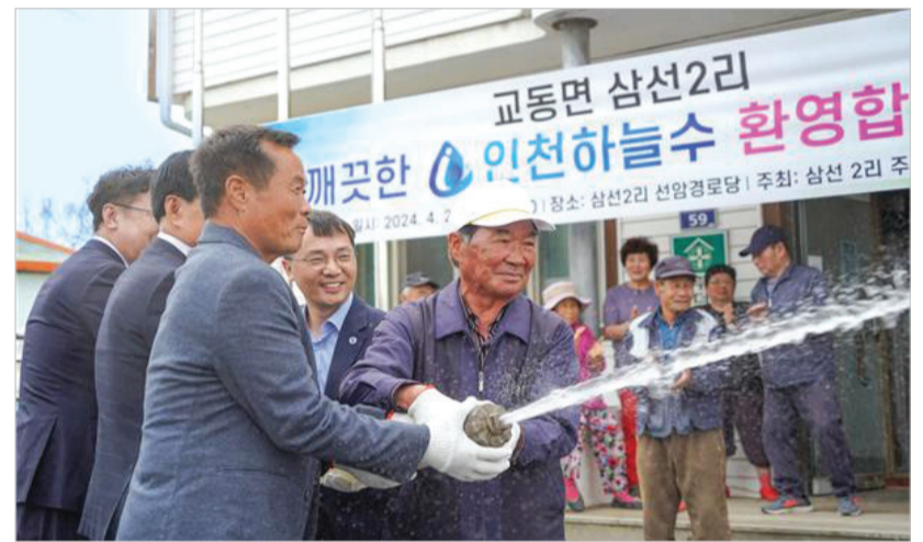
지방상수도 통수 전경
